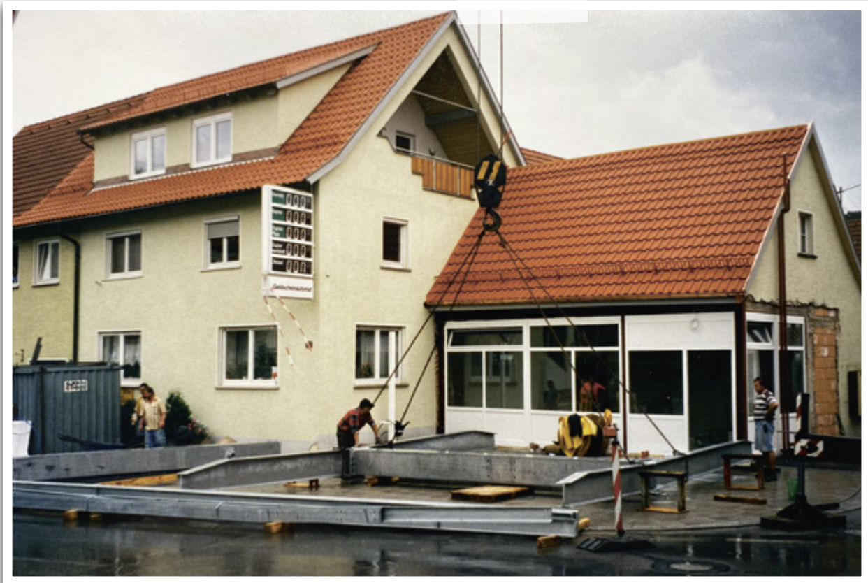
Der Bau des neuen Shops im Jahr 2001
