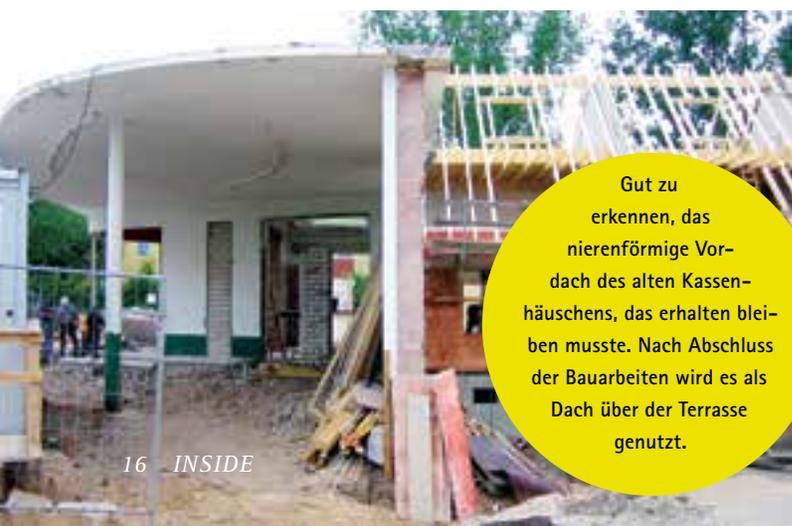
Gut zu erkennen, das nierenförmige Vordach des alten Kassenhäuschens, das erhalten bleiben musste. Nach Abschluss der Bauarbeiten wird es als Dach über der Terrasse genutzt.
